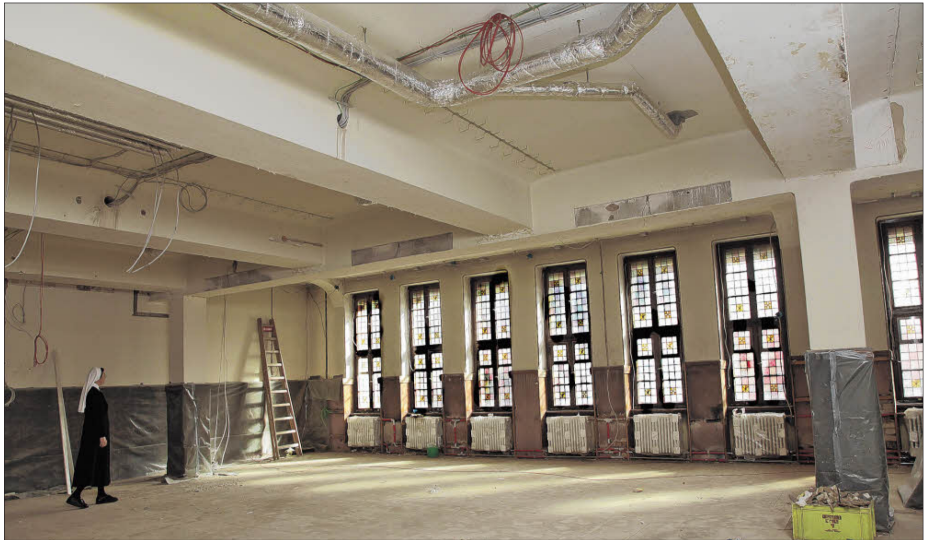
Sanierungsarbeiten im Sankt-Vinzent-Kloster in Heppenheim.
